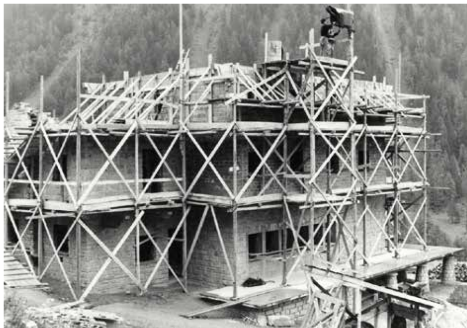
Costruzione del rifugio Natale Reviglio anni 1957-1958
