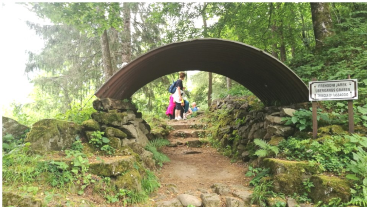
Il sito della testa di ponte e prima linea austro-ungarica a Ravelnik
