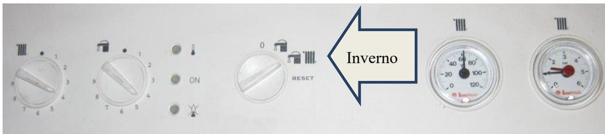
A seconda della stagione, se necessario, agire sulla manopola **estate/inverno** (*terza*) e su quella che regola la temperatura dell'acqua calda di doccia e lavandini (*seconda*), **portandola tra il 4 ed il 5.**
