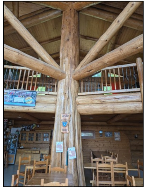
Il grosso tronco di cedro, struttura portante (Foto Egle Marchello)
