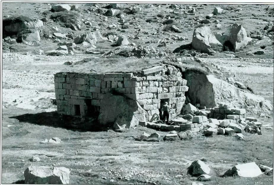
Il nucleo di base del rifugio Salarno, oggi, praticamente intatto. Si nota il suo essere addossato al grande masso che ne costituisce una parete e la robustezza delle pareti di enorme spessore (da 1 a 1,5 metri). Il pietrame sparso sul terreno è quello del più leggero avancorpo realizzato successivamente.
