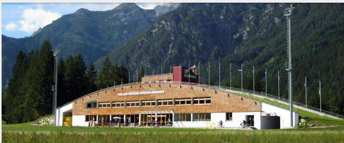
La palestra di arrampicata sportiva NORDIC ARENA di Dobbiaco 15-06-17 - (Foto da web)
